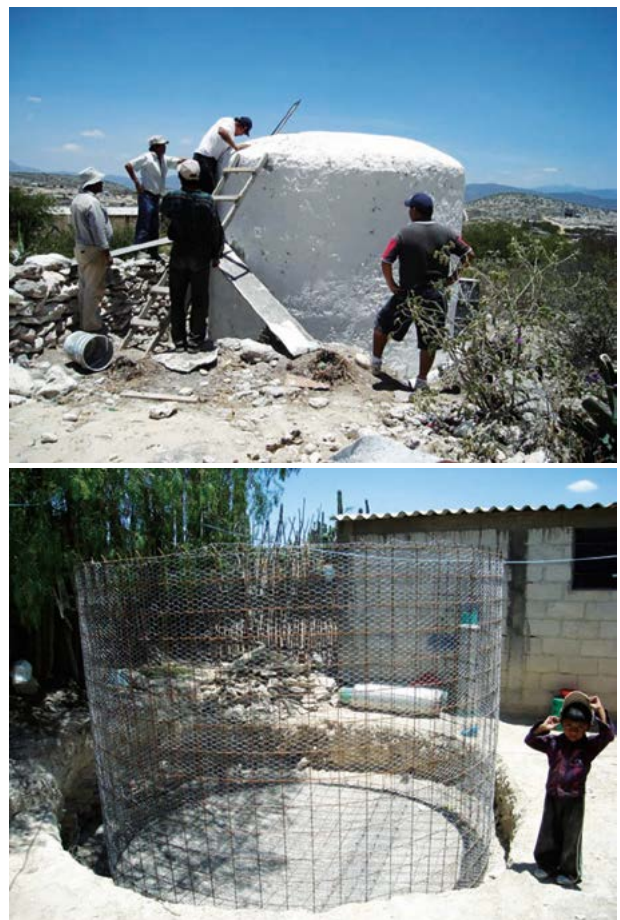
Figura 2. Construcción de cisternas de ferrocemento.
