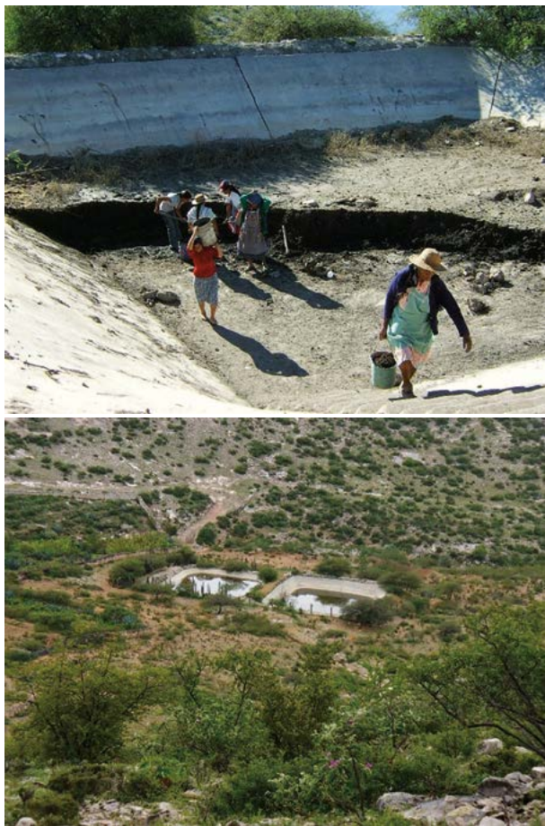
Figura 1. Construcción de infraestructura para captación de agua.
